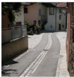
La zone de rencontre peut s'appliquer aux rues trop étroites pour disposer de trottoirs assez larges pour respecter les règles d'accessibilité.
